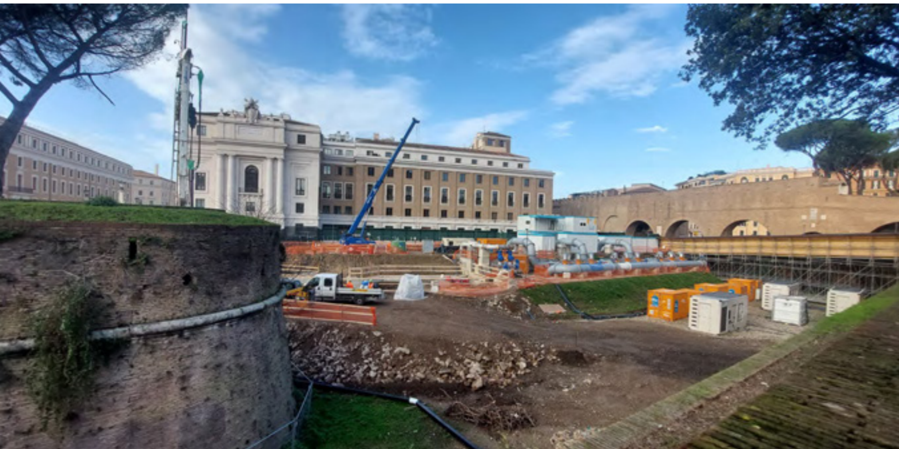
Costruzione del nuovo collettore fognario ©arch. Felipe Lozano Lalinde
