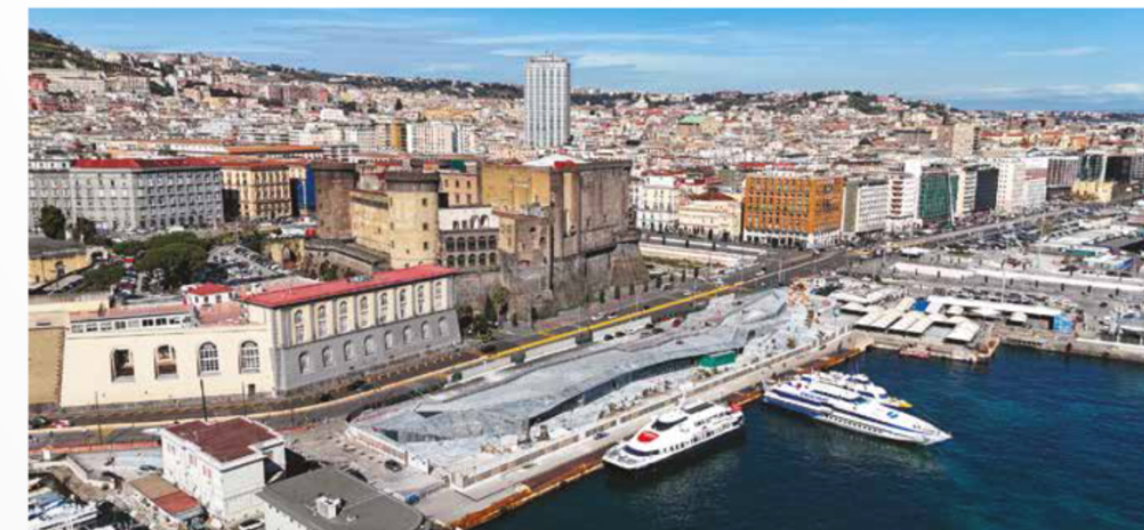
Sopra, veduta della città di Napoli con dettagli dell'opera di riqualificazione del Molo Beverello all'interno del contesto del lungomare di Napoli
