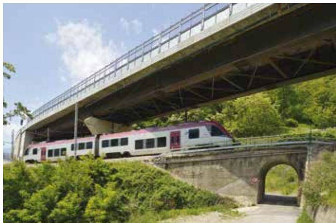
6. Il viadotto 5 a lavori ultimati
