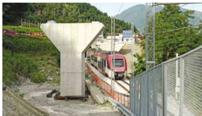
5. La realizzazione del viadotto 5 con interferenza del traffico ferroviario
