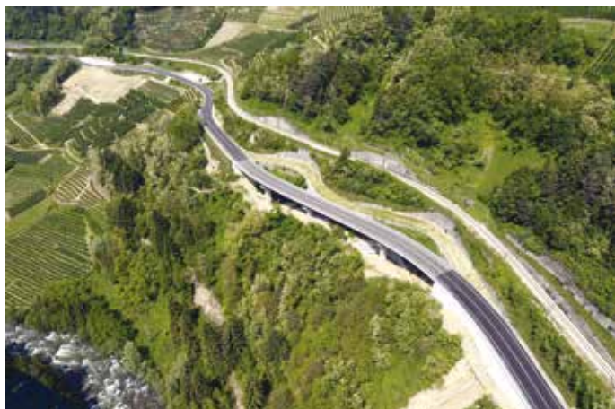
2. Vista aerea del viadotto 1
