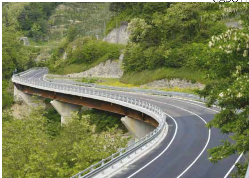
3. Il viadotto 1 a lavori ultimati
