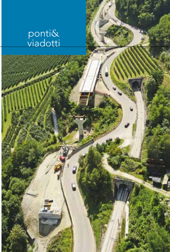
4. Vista aerea del varo a spinta del viadotto 4
