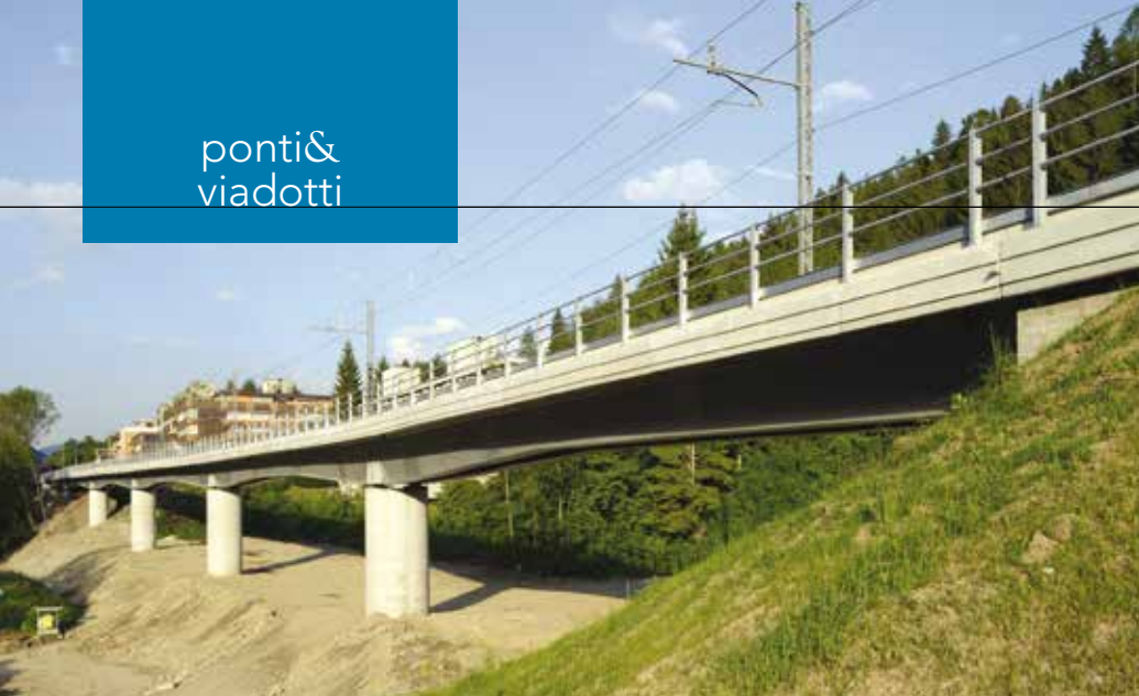
10. Il viadotto ferroviario
