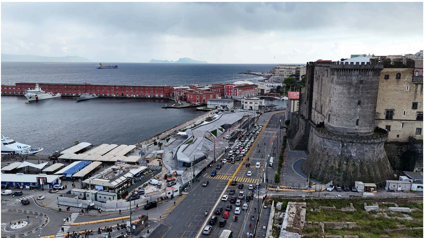
Il cantiere di tipo lineare semi-ipogeo del Molo Beverello quasi ultimato
